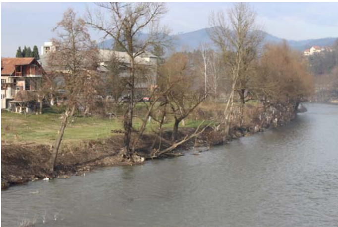
Die Ambulanz wurde von diesem Fluss überschwemmt.
