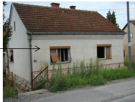
Bis stand das Wasser in diesem Haus
