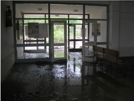
Die Eingangshalle der Ambulanz in Doboj
